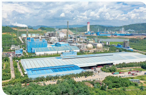
云南祥丰集团部分厂区
