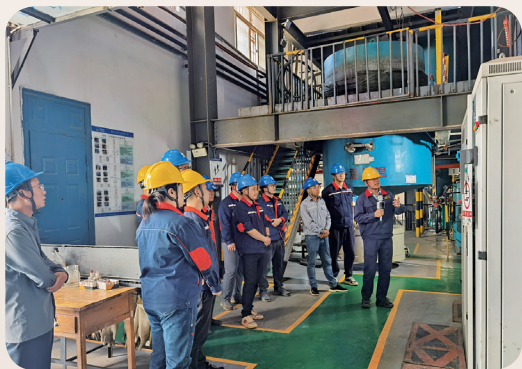
解吸一车间 A 柱解吸电解系统升级改善项目
